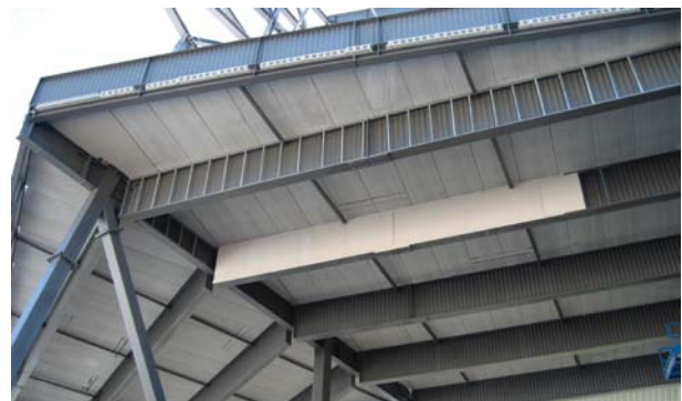
Verteilerebene Stadion Innsbruck 7.000 m 2 Hohldielen mit Nut und Feder
