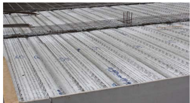
Mitarbeiterhaus Sonngrub, Kitzbühel 1.200 m 2 Vorgespannte Elementdecke 2.300 m 2 Hohlwände
